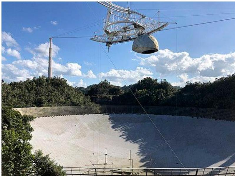
Die Abbildung zeigt das William-E.-Gordon-Teleskop des Arecibo-Observatoriums in der Nähe von Arecibo auf der Karibikinsel Puerto Rico. Dieses Radioteleskop hat einen Durchmesser von 305 Metern und wurde zur Untersuchung der Ionosphäre mit einem Radiowellensender ausgestattet. An der Ionosphäre reflektierte Radiowellen konnten somit untersucht werden.
